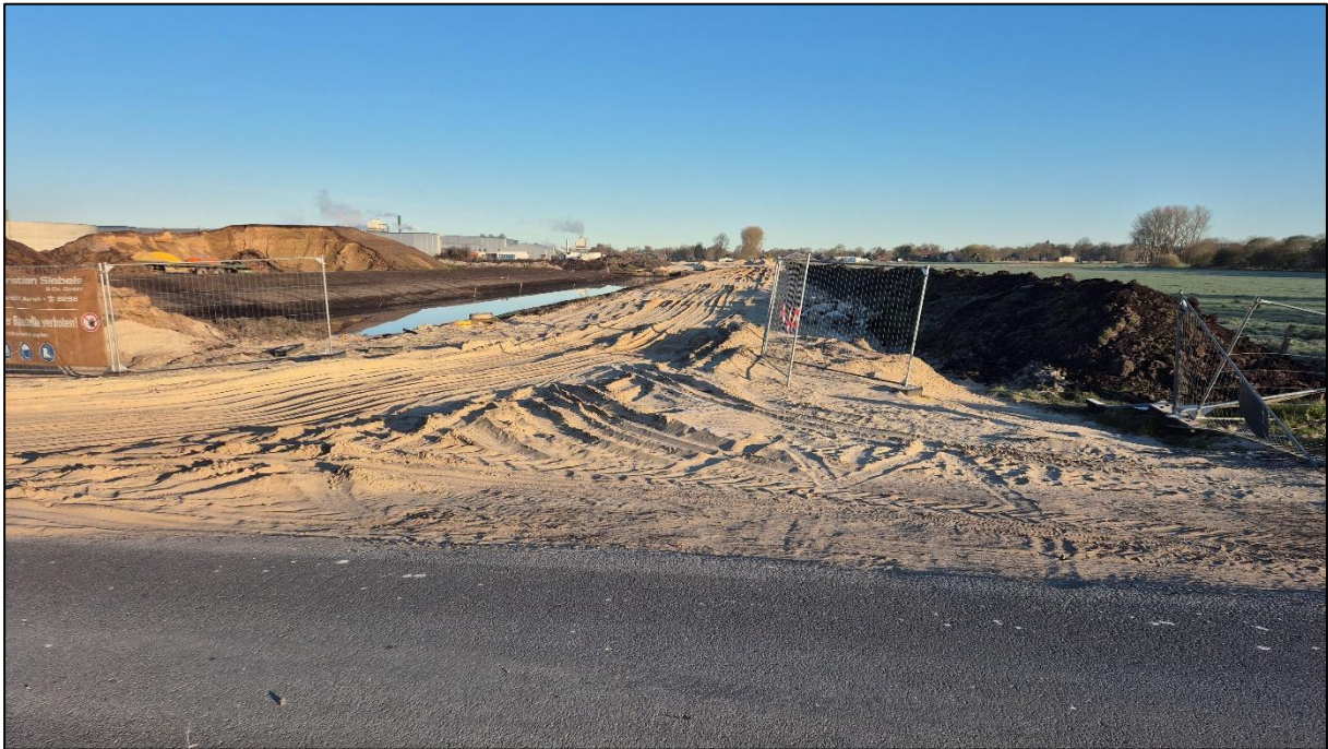
Abbildung 4: Baustelle am 1. Querweg (Datum: 04.07.2025)
