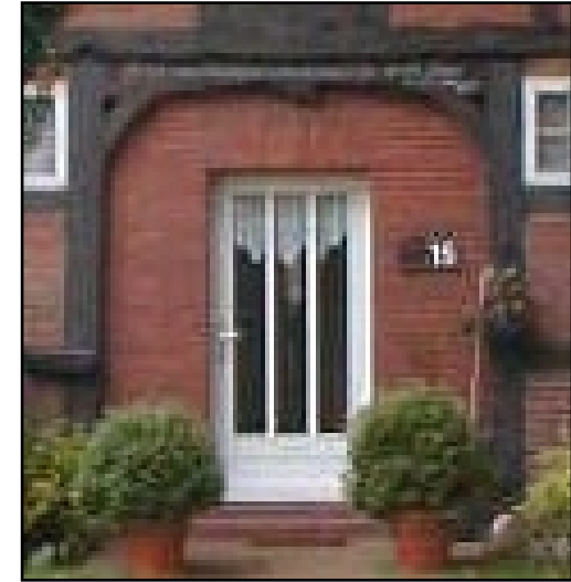
Beispiel für eine ortsuntypische Sanierung
