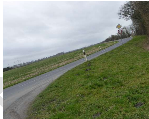
Abbildung 41: Emder Straße (K 137) in Richtung Emden
