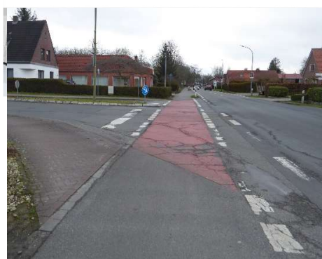
Abbildung 49: Abgenutzte Furtmarkierung
