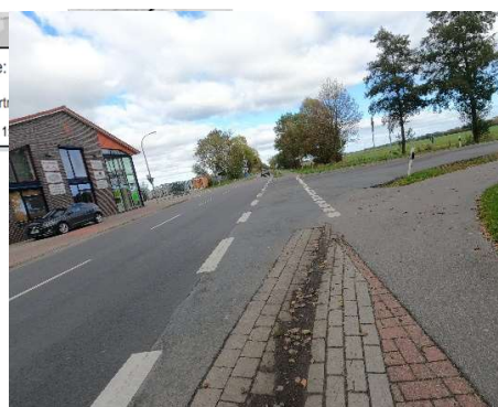
Abbildung 50: Fehlerhafte Furtmarkierung
