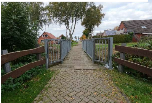
Abbildung 51: Engstelle Brücke Fasanenstraße
