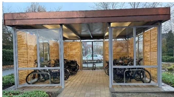
Abbildung 64: Radabstellanlage Rathaus Cloppenburg
